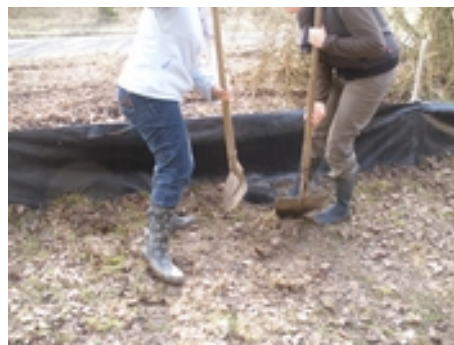
Installation du barrage – V. Coffinet
